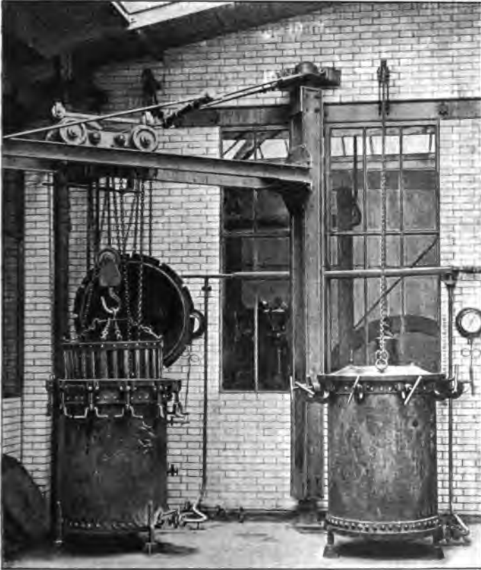
Autoclaves servant à stériliser les conserves (Usine Félix Potin). — On voit, à gauche, un autoclave ouvert; le panier métallique servant à placer les boîtes est en partie hissé par le palan. A droite, autoclave fermé.
